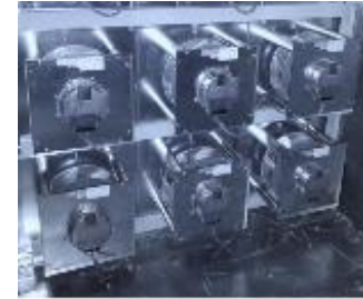
EC Fan Wall
